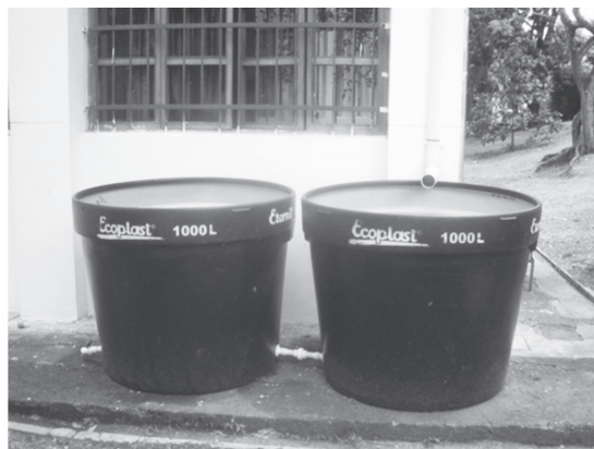
Foto 1. Sistema piloto de captación y almacenamiento de agua lluvia en la I.U. Colegio Mayor de Antioquia
