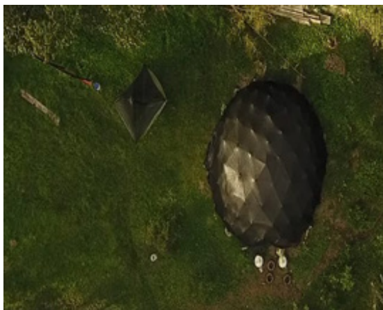
Figura 5. Estructuras captadoras de niebla
